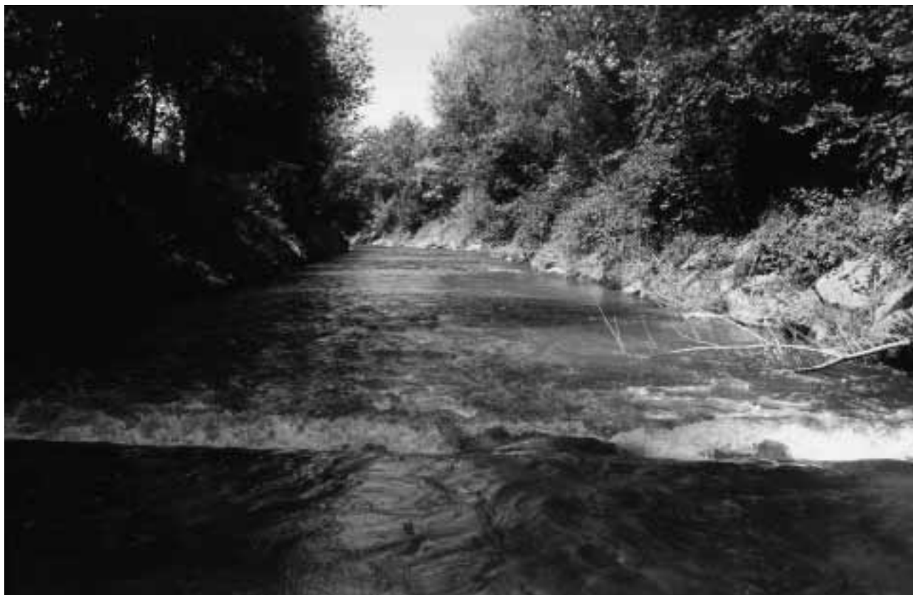
Abbildung 1: Wigger bei Schötz: Fließgewässer mit Sohlschwellen, stark kolmatisierte Gewässersohle. (Foto: A. Peter, EAWAG)
