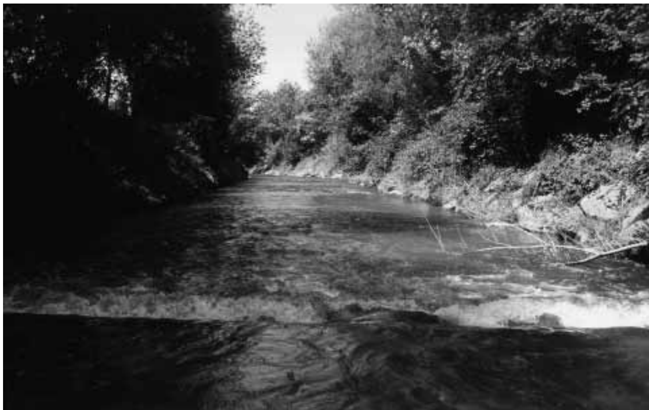
Figure 1: La Wigger à la hauteur de Schötz: un cours d'eau présentant des obstacles à l'écoulement et un lit fortement colmaté. (Photo: A. Peter, EAWAG)
